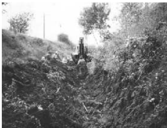
Săpături cu escavatorul organizate de Árpád Bereczky (Căciulați)
